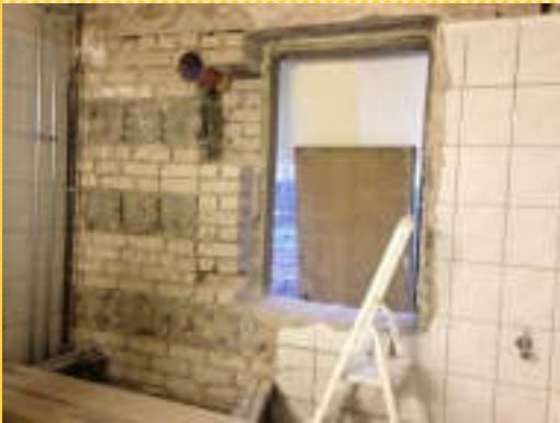
Ausbau weiterer Toiletten und Behinderten-WC
