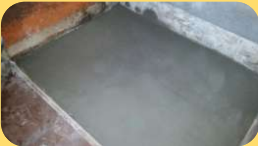
Erneuerung des Kugelauslaufes auf der Kegelbahn
