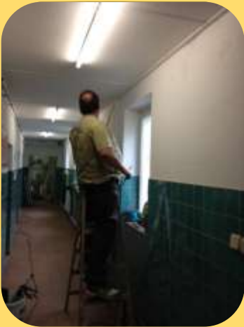
Beginn Einbau Trockenbaudecke im Flur
